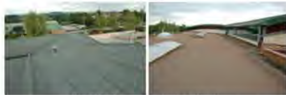
Etanchéité bicouche bitumineuse à rénover
